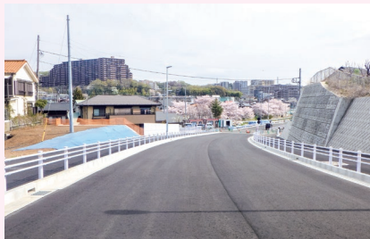
開通に向け工事中の宮上横山線
