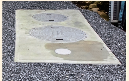
合併処理浄化槽への転換が完了した様子
