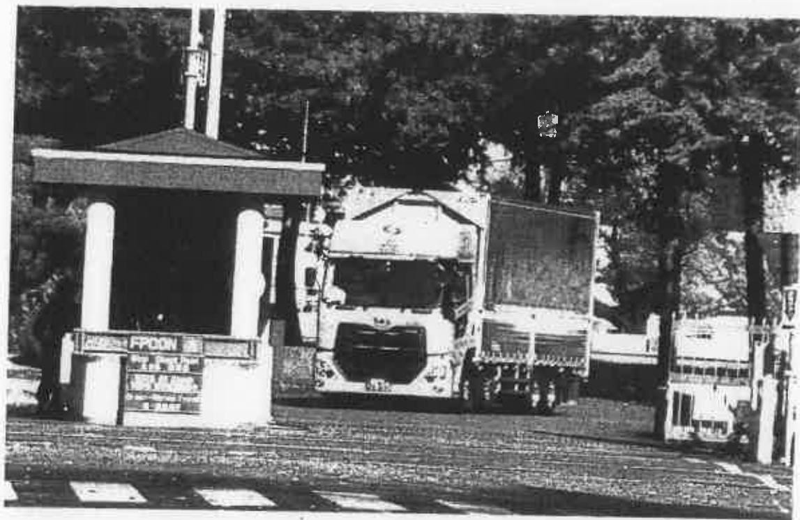
大型倉庫の補修工事が進む
