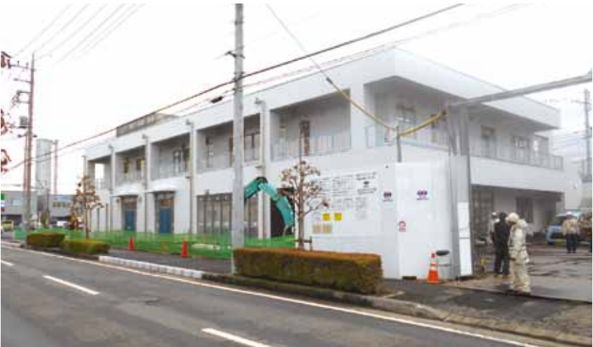
移転整備中の麻溝まちづくりセンター・公民館
