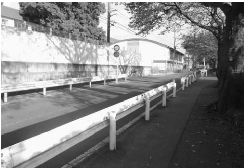
通学路のガードレール
