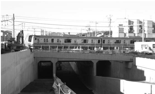
整備中の相原宮下線（元橋本町付近）
