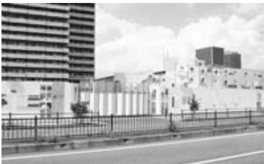
(仮称) 緑区合同庁舎建設現場
