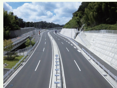
津久井広域道路(相模原インターチェンジ付近)
