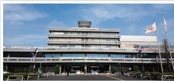
市役所本庁舎外観
