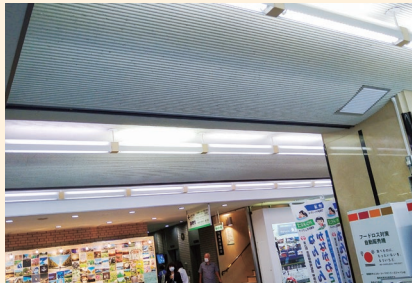
市役所本庁舎内のLED照明
