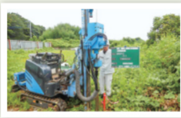
土壌汚染状況調査の様子
