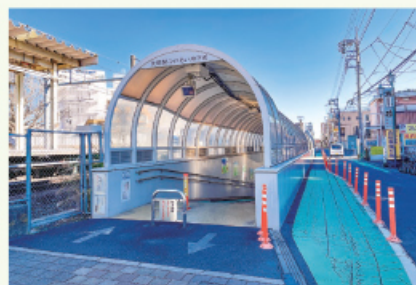
矢部駅ふれあい地下道
