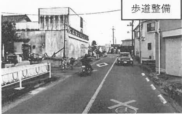
1-(2) 大島交差点～北清掃入口交差点 大沢小学校～大島交差点
