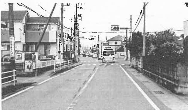
2-(1) 大島交差点 右折レーン設置
